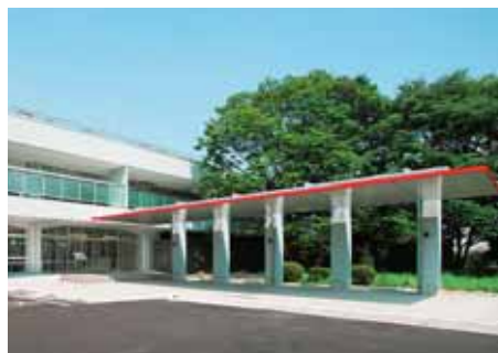
玄関庇（キャノピー）
