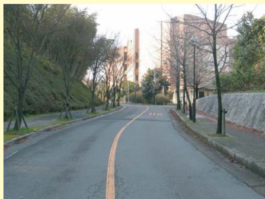
上りのアプローチの正面という、アイスストップとして格好の位置に建つレーザー研の施設であるが、巨大な壁面が聳える魅力の乏しいものとなっている。
