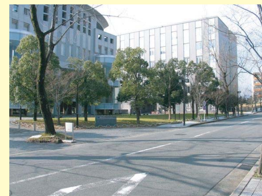
開放性の高い並木と広場が道路と建物の関係を良好に保つ
