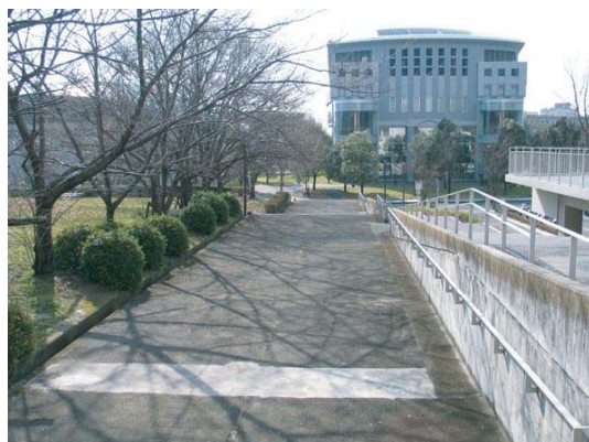
広いオープンスペースに面しているのに、全く関係性をもたないコンクリート舗装の歩行者通路
