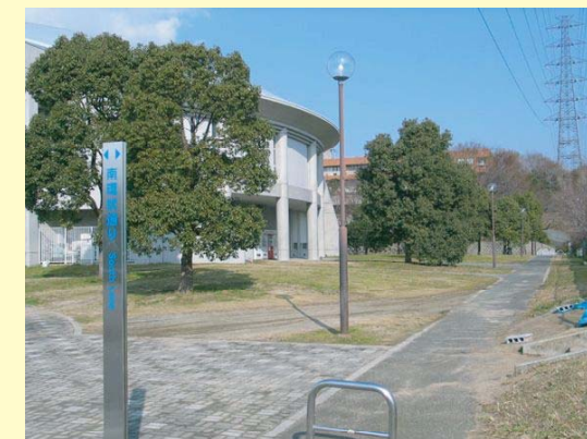
通路と植栽の間に明確な境界がなく、緑をより身近に感じることができる
