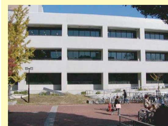
すっきりした建物際の例。
