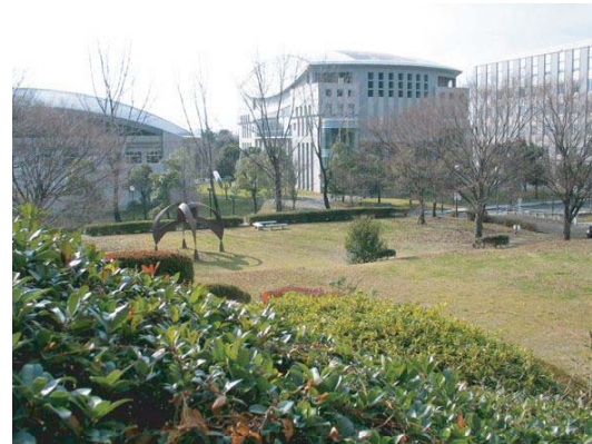
8. 本部南側広場 オープンスペースの連続が広がりのある空間をつくる
