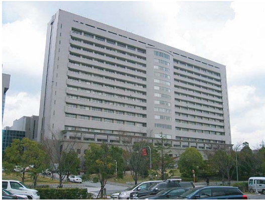
1. 医学部付属病院 高層棟は周辺地域のランドマークとなっている
