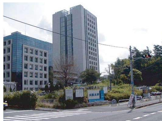
18. GSE棟 高層棟はキャンパス西部のランドマークである
