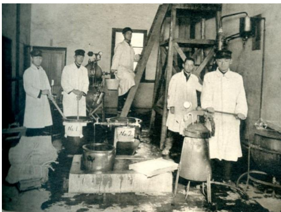
大阪高等工業学校蒸溜機室
