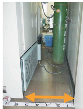
図 3.8 フリーザーの背面の隙間（500 mm）
