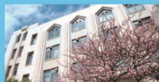
大阪大学 大学会館
