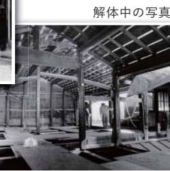
解体中の写真
