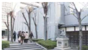
改修工事中の適塾 (本年2月)
