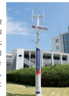
▲8月 吹田キャンパスに設置された実験用の独立電源通信網「みまもりロボくんⅢ」
