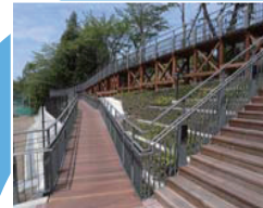
阪大東口(豊中) (平成21年3月環境整備工事竣工)
