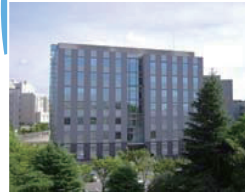
情報系先端融合科学研究棟(吹田) (平成20年12月新棟竣工)
