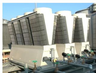
レーザーエネルギー学研究センターに設置された空冷モジュールチラー
