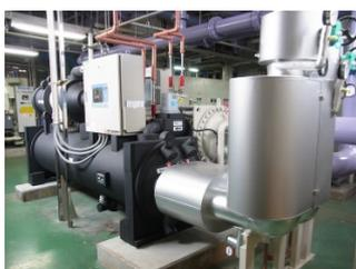
核物理研究センターに設置されたインバーターターボ冷凍機
