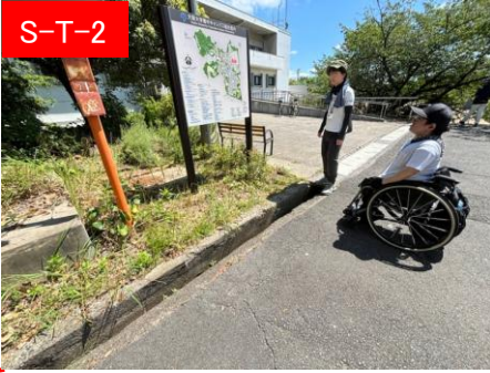
S-T-2 サインの前に溝がある。排水溝の蓋がされ ていない。
