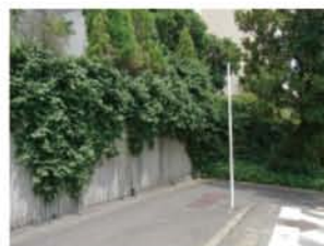
擁壁面の緑化。 (箕面キャンパスA棟南側)
