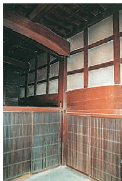
土間上部の力強い梁架構
