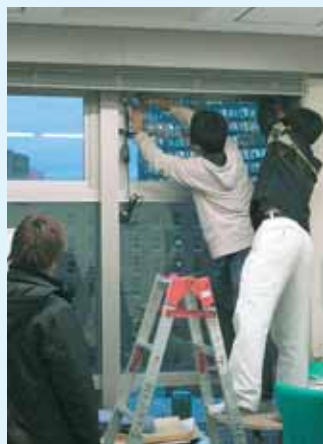
LEDの取付けは 学生も作業を行いました
