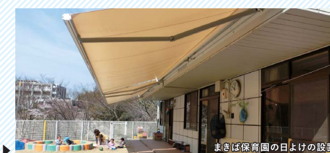
あれこれ施設整備しています▶
