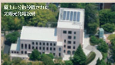
今回の改修では、耐震・老朽改修にあわせて、文化財としての外観の保護に配慮しつつ、建物の断熱化、LED照明をはじめとする省エネ機器への更新、新エネルギーとして太陽光発電パネルを設置するなど、省エネルギー化、低炭素化を図る対策を行っている。
