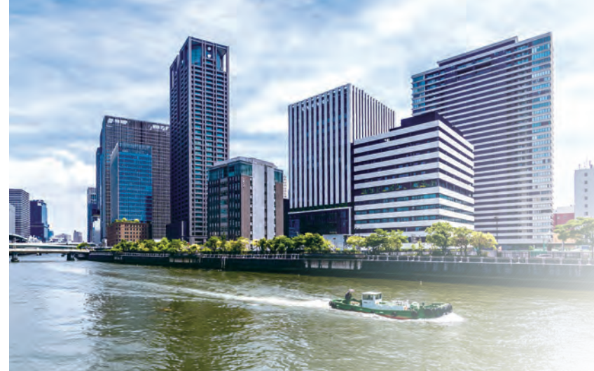
縦横の白いラインが印象的なNakanoshima Cross。 2階には大阪ヘルスケアパビリオン展示物の一部も移設されている。
