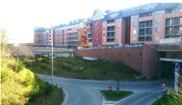
図 c3a 人工地盤とその上部の建物の様子(1)
