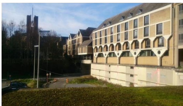
図 c3b 人工地盤とその上部の建物の様子(2)
