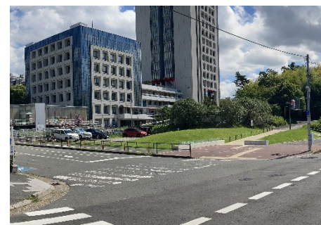
18 工学U1M棟(GSE 高層棟) 高層棟はキャンパス西部のランドマークである
