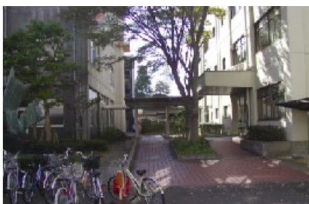
12A 文系ゾーン 建物の入り口が街路からの引きを多くとっている
