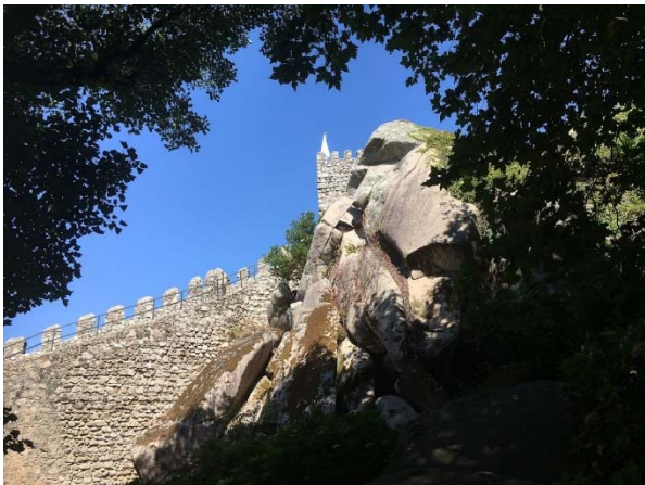
←岩の上に石造建築が建てられている。
