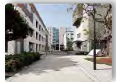
豊中総合学館 全学教育 A 棟 基礎工学 A 棟 理学 A 棟
