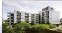
工学研究科研究棟改修 (～平成20年度継続)
