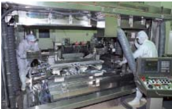
稼働時は巨大な超純水の水槽となるEEM加工装置
