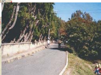
5 駐車防止ブロックが美観を損ねるとともに、人の通行の障害ともなっている。
