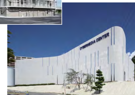
サイバーメディアセンターITコア棟
