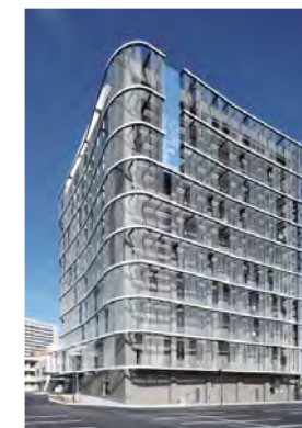
生命システム棟
