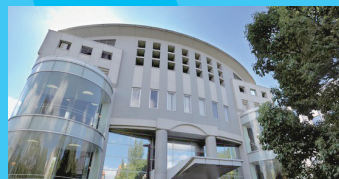
大阪大学 コンベンションセンター
