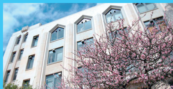
大阪大学 大学会館
